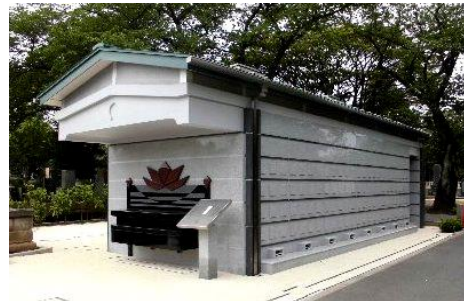
立体埋蔵施設（谷中霊園） 使用許可日から起算して20年間は、遺骨を地上のカロートに個別に埋蔵し、その後は地下に共同埋蔵します。
