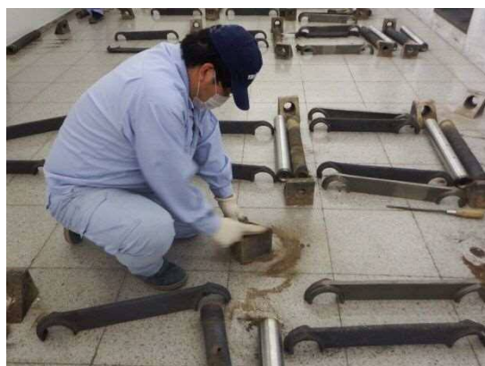
ロストル（火葬炉内器具）のメンテナンス
