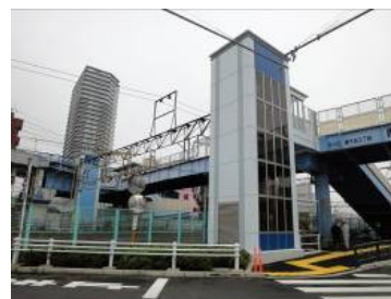
<横断歩道橋のエレベーター整備例>
