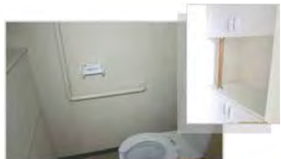
立上り動作が必要な場所及び 段差が残る場所には手摺を設置
