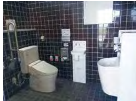
<手すり等を装備したトイレの例>
