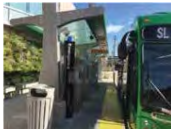
<上屋を設けた停留施設の例> (アメリカ合衆国ミシガン州 グランドラピッズ)
