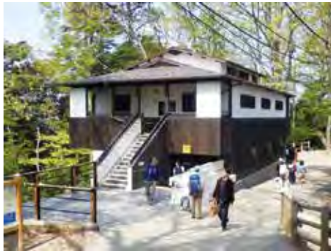
<大見晴園地のトイレ外観>
