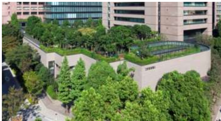
江戸のみどり登録緑地 三井住友海上駿河台ビル 及び駿河台新館（千代田区）
