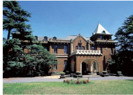
旧前田家本邸洋館 (目黒区) 旧華族の邸宅 旧加賀藩主の系譜を引く前田利為の本邸として、昭和4年に竣工した。通常は公開していない部分も公開する。 公開日 10月26日～11月4日
