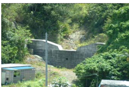
八ツ瀬川砂防施設
