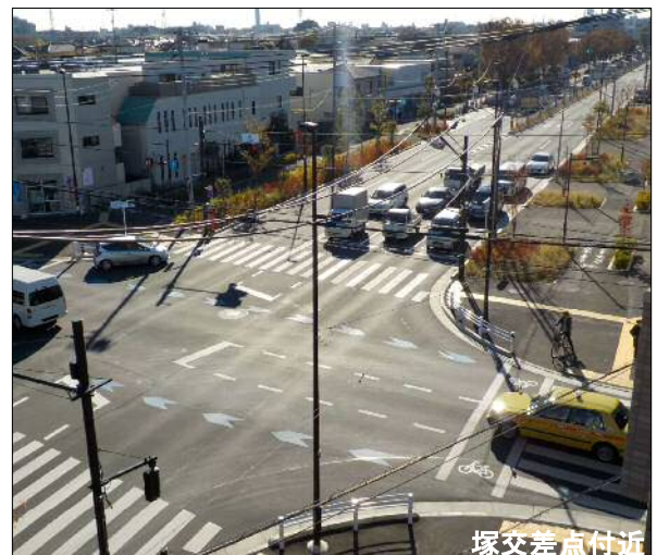
4車線交通開放後
