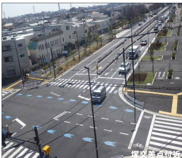
4車線交通開放前
