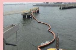
海上災害時の応急措置の例 (オイルフェンスの展張)
