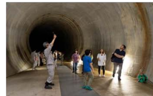
古川地下調節池
