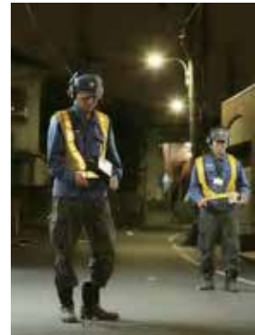
夜間を実施する音聴調査の様子 (地下漏水の早期発見)
