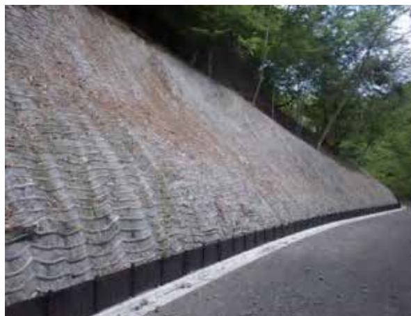
自然侵入促進型植生マットを活用した林道整備
