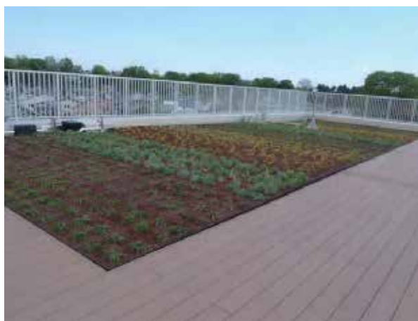
羽村取水所の屋上緑化
