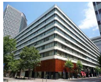
【新東京ビル 外観】
