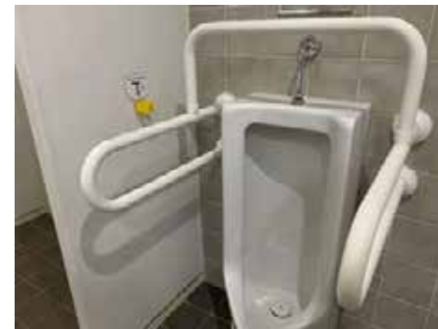
手すりの設置
