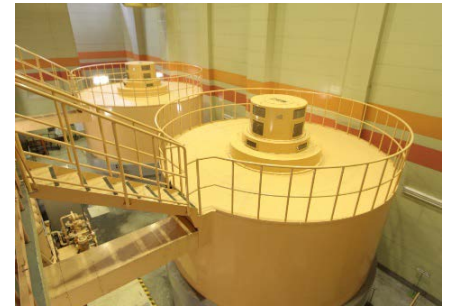
多摩川第三発電所
