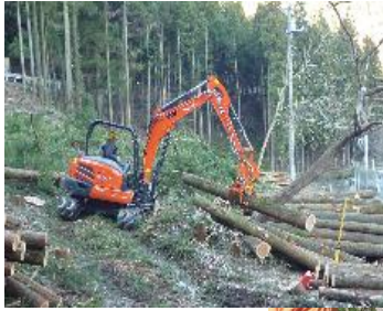
重機による伐採木整理
