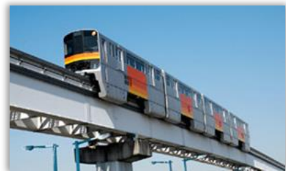
(写真：多摩都市モノレールHPより)
