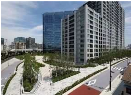
図IV-20 市街地再開発事業による 無電柱化事例 (品川区西品川 西品川一丁目地区)
