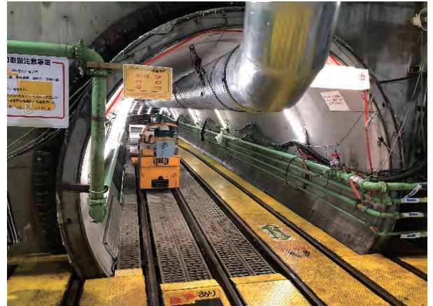
呑川増強幹線工事現場 令和3年7月8日監査人撮影
