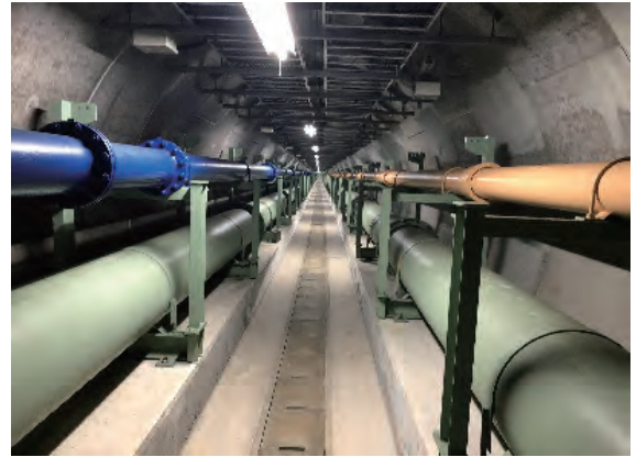
北多摩一号水再生センター・南多摩水再生 センター間連絡管 令和3年7月9日監査人撮影
