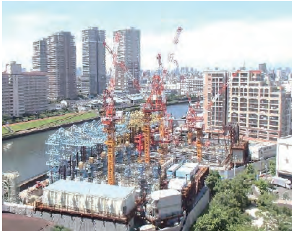
千住関屋ポンプ所工事現場 都提供資料より
