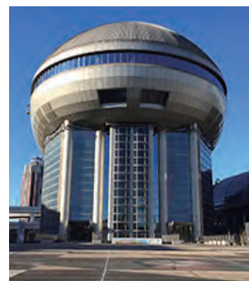
東京都虹の下水道館（外観） 東京都虹の下水道館ホームページより引用
