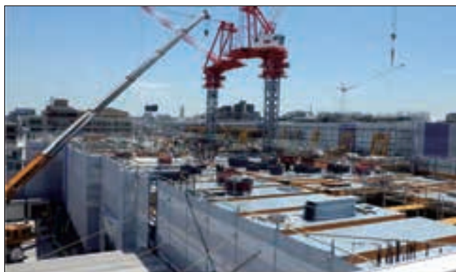
【工事中の都立特別支援学校の例】
