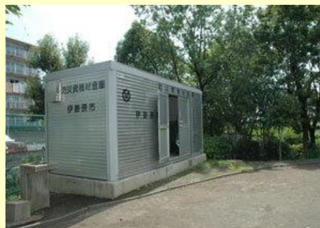
防災対応 (例：防災備蓄倉庫)
