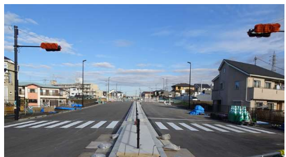
【多摩橋通り側から都道第165号線方面を望む】
