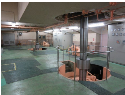
多摩川第一発電所
