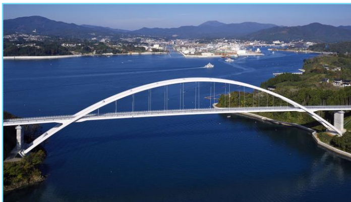
平成31年4月 気仙沼大島大橋が完成
