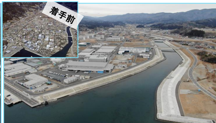
令和4年4月 鹿折川(気仙沼市) 被災した河川堤防をL1の高さで復旧
