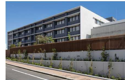
都立学校の外構における木柵整備
