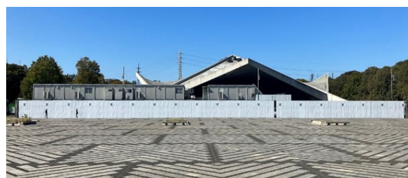
当初の工事現場状況
