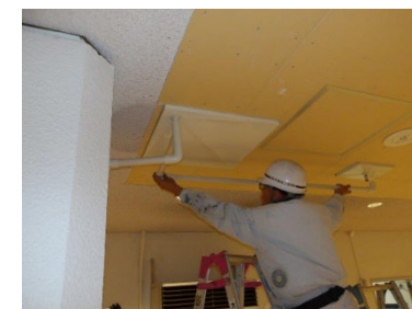
雨漏り対策工事
