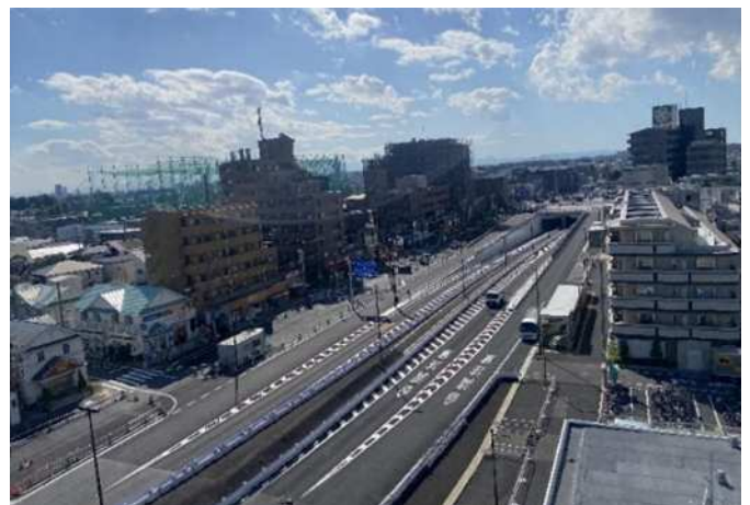
平和台トンネルの全景
