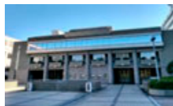
立川地域防災センター
