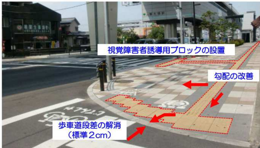
図4-1 バリアフリー化整備事例（尾久橋通り<扇大橋駅周辺>）
