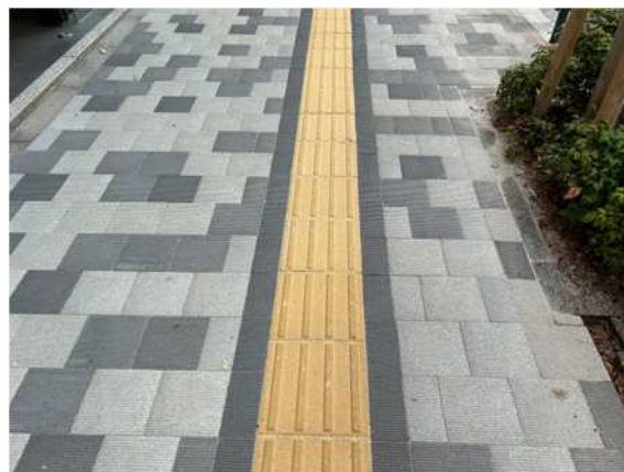
図 4-9 輝度比を考慮した視覚障害者誘導用ブロックの設置例
